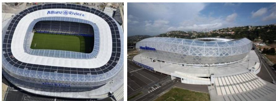
*Membrane en ETFE transparent pour la partie qui recouvre l'arrière des tribunes ainsi que pour l'extrémité du toit des tribunes. Toutefois, la plus grande partie de ce toit est constitué d'une membrane en PVDF translucide ce qui assure la filtration de la lumière naturelle.*
